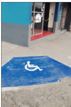
Imagen 51: Construcción de rampas de acceso Fuente:DOIUM
