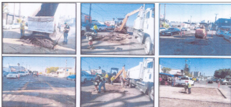
Imagen 49: Bacheo con mezcla asfáltica
