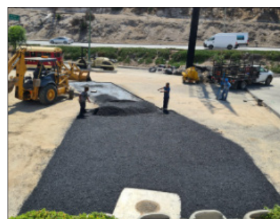
Imagen 52: Reposición de red pluvial Fuente:DOIUM
